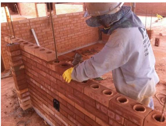
Figura 9: Assentamento dos tijolos de solo cimento
