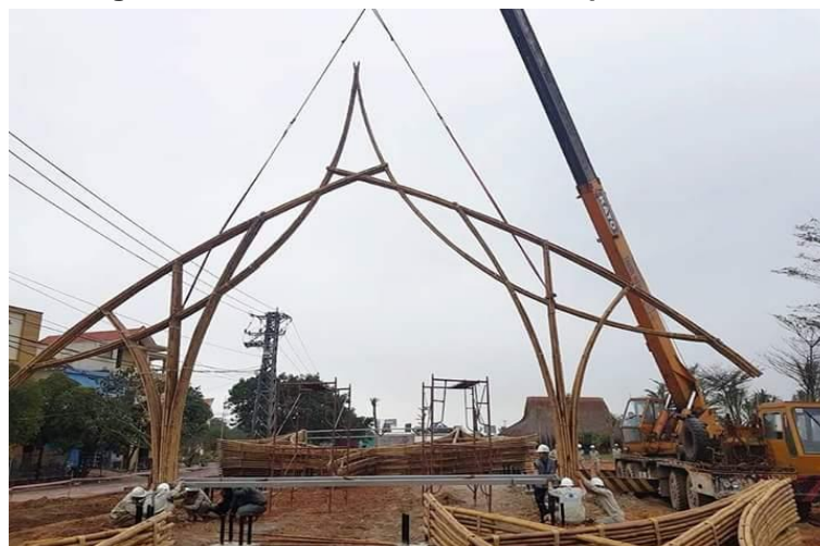
Figura 7 – Detalhe da tesoura sendo posicionada
