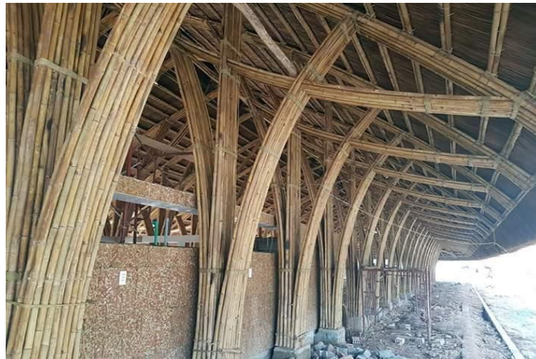
Figura 8 – Detalhe da tesoura sendo posicionada
