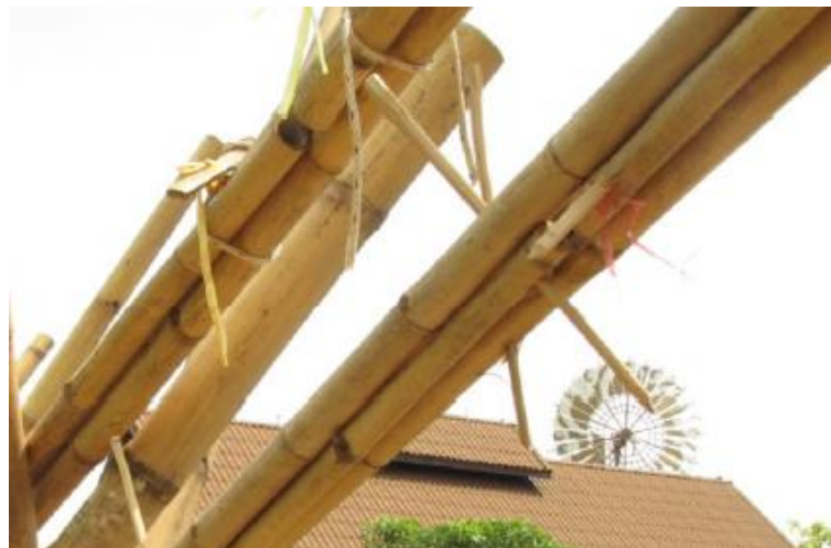
Figura 3 – Detalhe do feixe com bambu da espécie Dendrocalamus strictus
