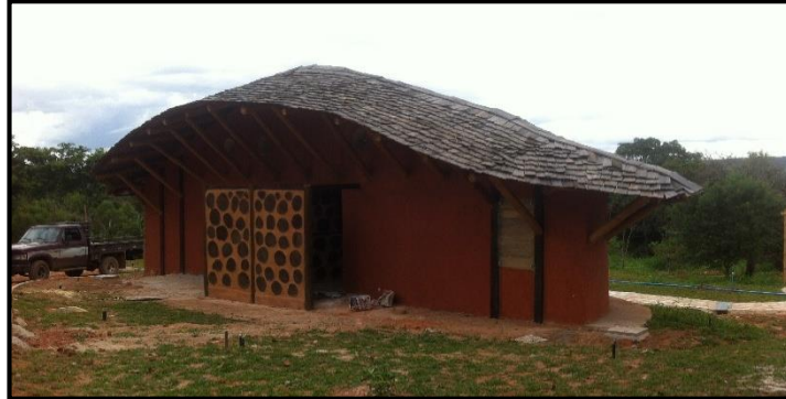
Figura 04: Prédio de sanitários
